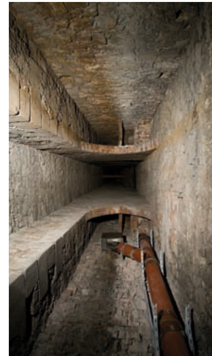
Links: Blick in den noch bestehenden historischen Abortschacht im Südflügel
