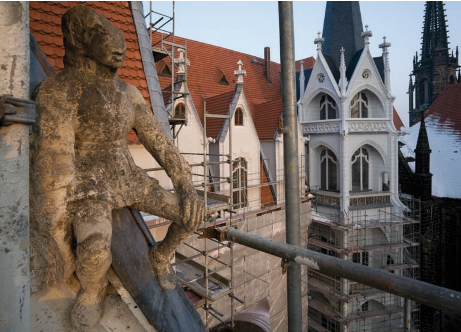
Sanierung der Fassaden am Mittelbau und am Großen Wendelstein
