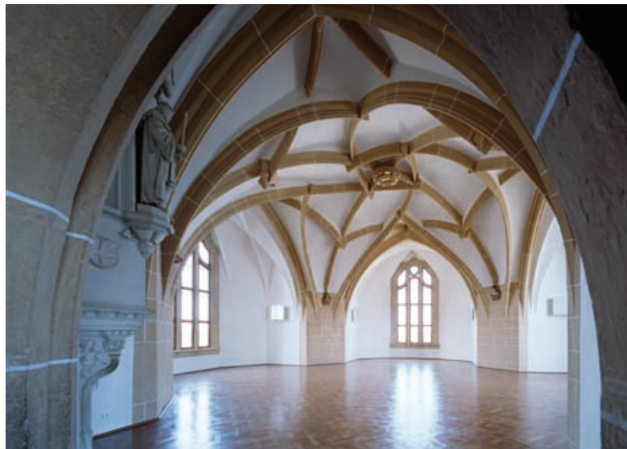
Rechte Seite: Restaurierte Felderdielung in der Ratsstube im 3. Obergeschoss
