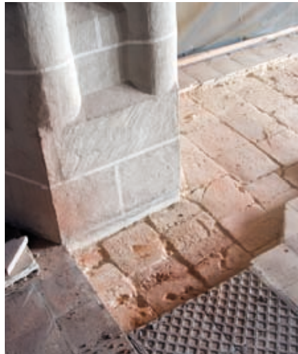
Oben: Folieneinhausung zum Schutz der historischen Wandbilder vor Staub
