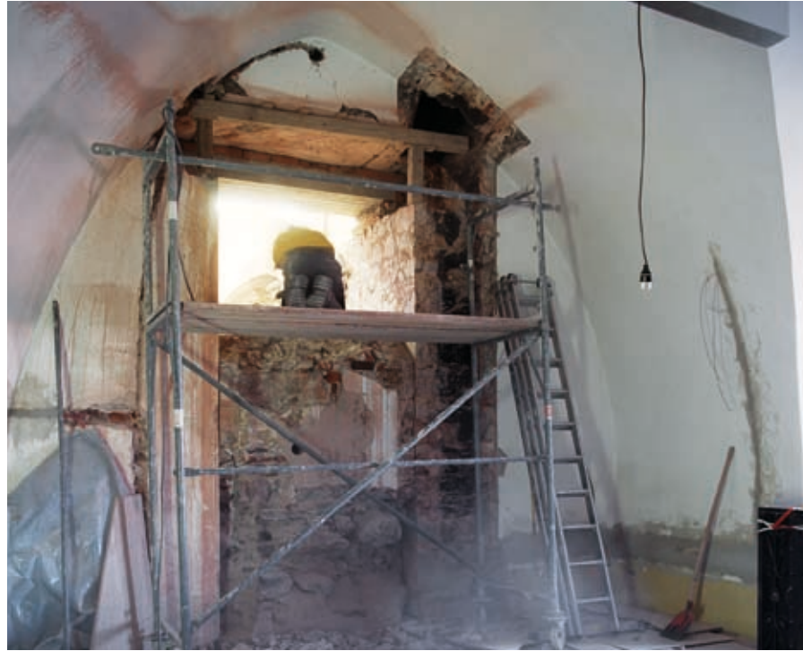
Wanddurchbruch zum Museumsshop
