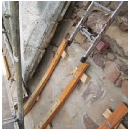
Oben rechts: Holzbalkendecke im Kaminzimmer, 3. Obergeschoss
