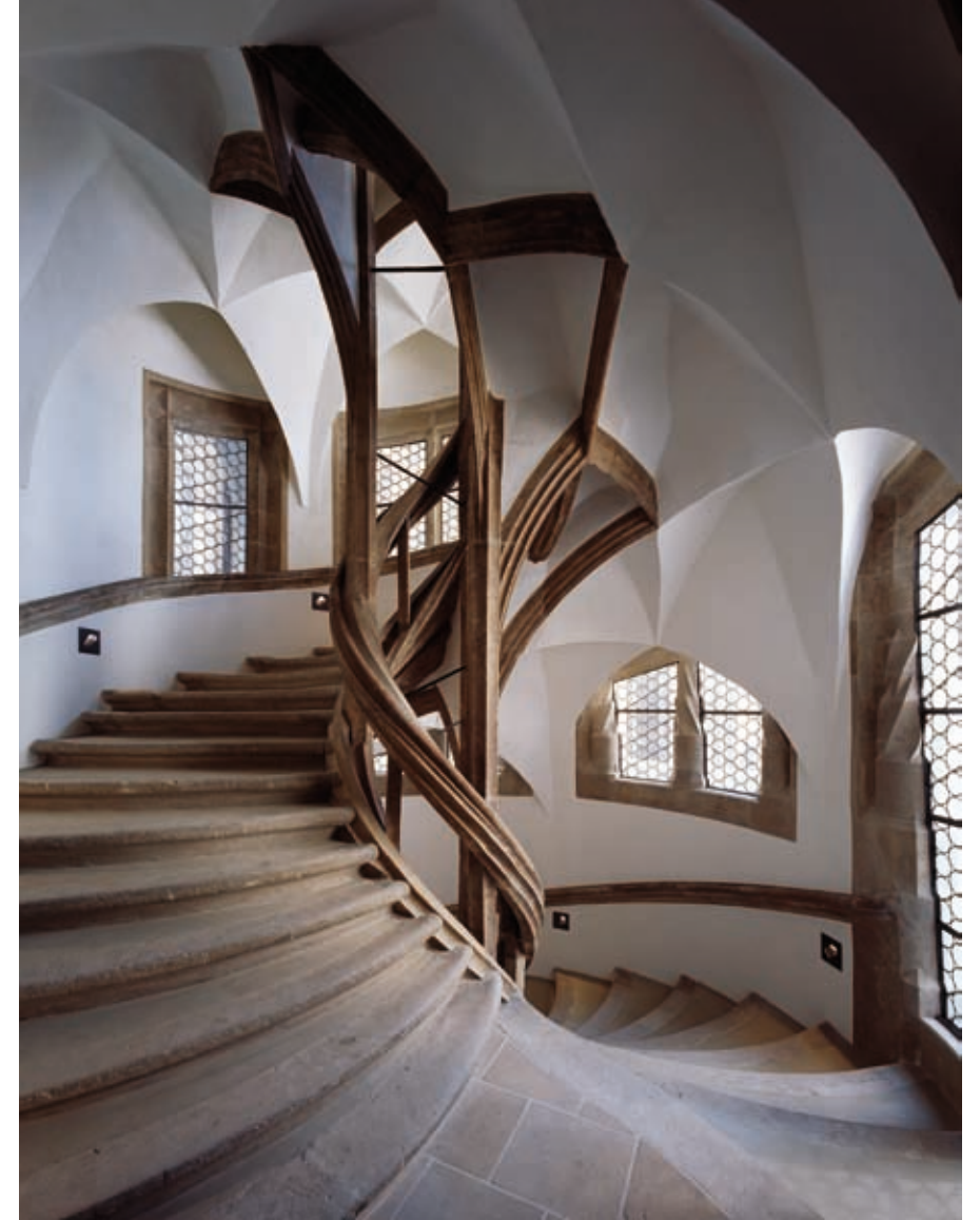
Spindel im 1. Obergeschoss
