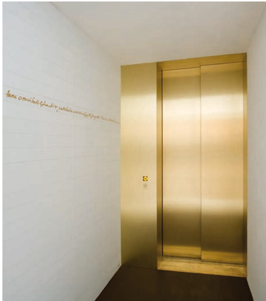
Zugang 3. Obergeschoss mit Aufzugstür aus Messing nach Fertigstellung
