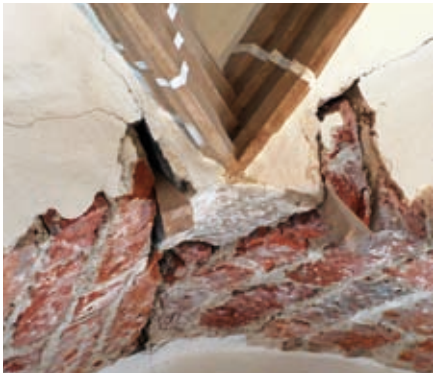
Aufnahme der Baustruktur der Wendelstein-Wandkonstruktionen
