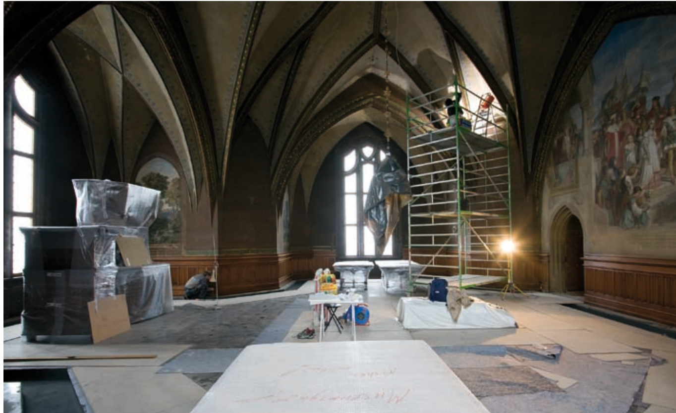
Restaurierungsarbeiten in der Kleinen Tafelstube
