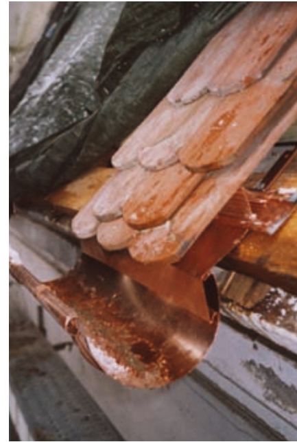
Links: Probeachse mit dem später ausgeführten Dachrinnensystem. Die untere Ziegelschicht ruht auf einer in Dreiecksform gekanteten Lüfterleiste.
