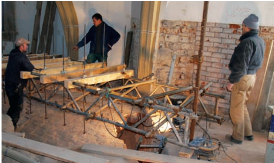
Während dem Anziehen der Spanten an einer Kappe
