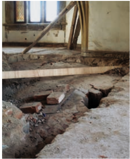
Spanten nach dem Einbau und vor dem Anziehen
