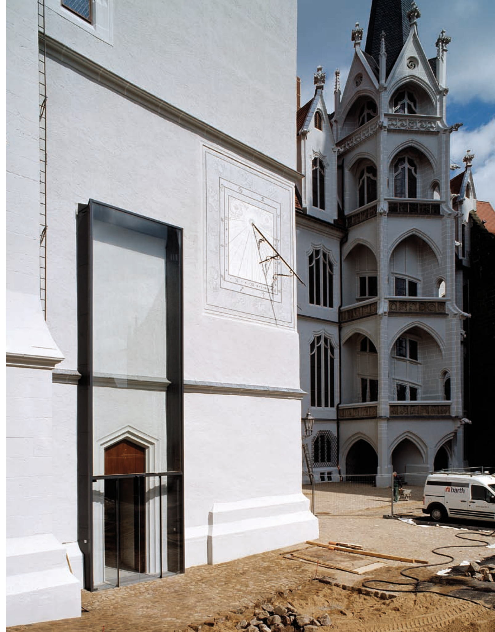
Der neue Eingang mit Stahl-Glas-Portal
