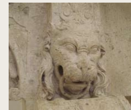
Löwenkopf, Detail des Kamin im Foyer Hasenhaus
