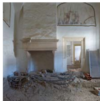
Foyer während der Bauarbeiten
