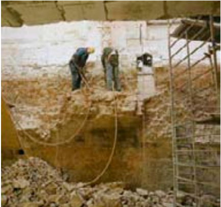
Abbrucharbeiten im Vorfeld der Errichtung des Schachts für den Kunstgut-Lastenaufzug
