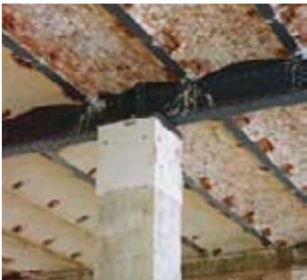
Die gründerzeitliche Konstruktion konnte erhalten bleiben und stellt durch die großen Spannweiten eine ideale Voraussetzung für eine flexible Raumnutzung dar.
