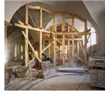
Zur Verbesserung der Orientierung wurden einige Trennwände abgebrochen. Hierzu musste der Bestand ersatzweise ertüchtigt werden.
