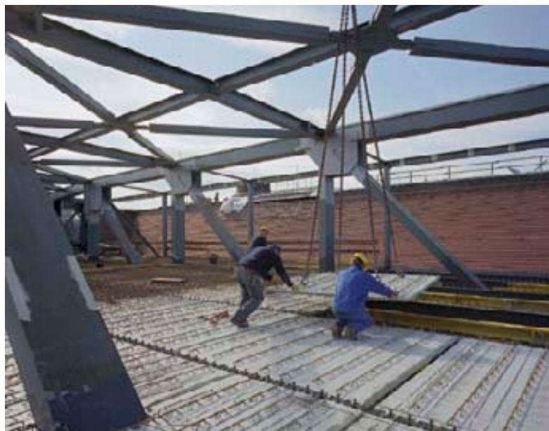
Um den Bauablauf nachträglich zu beschleunigen, wurden anstelle von Ortbeton Fertigteile für die Deckenkonstruktionen eingesetzt.
