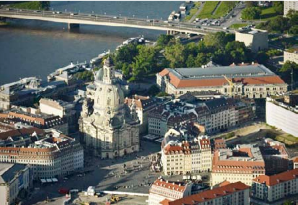
Das ergänzte Bauteil wird nach außen nur im Luftbild erkennbar. In der sensiblen Innenstadtlage ergeben sich keine städtebaulichen Auswirkungen.
