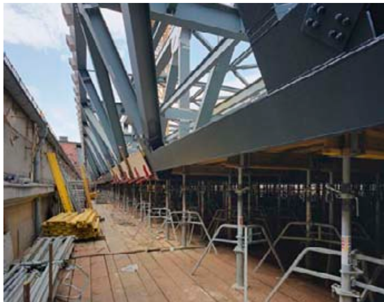
Bereich des unteren Gurts – spätere Lichtfuge des Innenhofs, die Teleskopstützen dienen dem Einbau der unteren Decke (Gemäldedepot).
