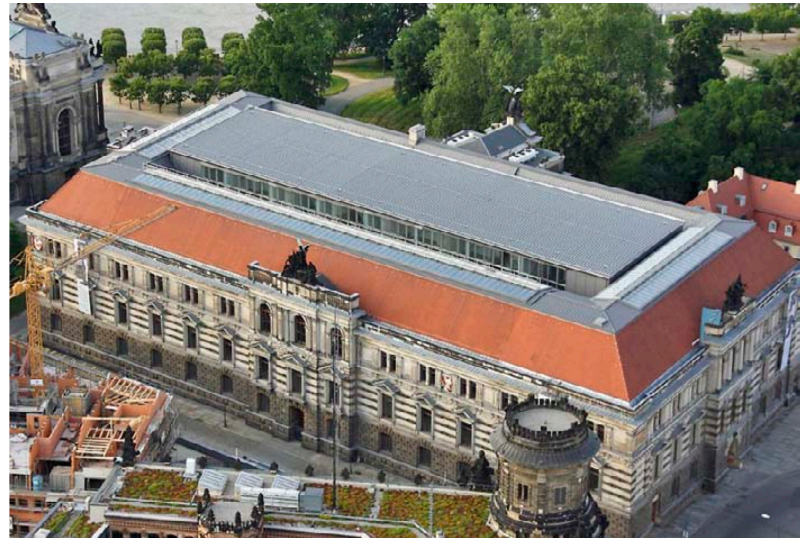
Die Werkstätten befinden sich im oberen Geschoss des Neubaus. Die Deckung aller nach innen gewandten Flächen des Bestandsdaches wurde durch eine graue Verblechung ersetzt, um Verfärbungen des Tageslichtes, die die Bildrestaurierung beeinträchtigen würden, weitgehend auszuschließen.
