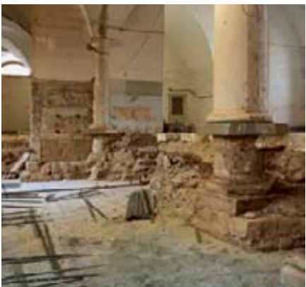
An den Säulen erkennt man sowohl das ursprüngliche als auch das später geschaffene, höhere Fußbodenniveau.
