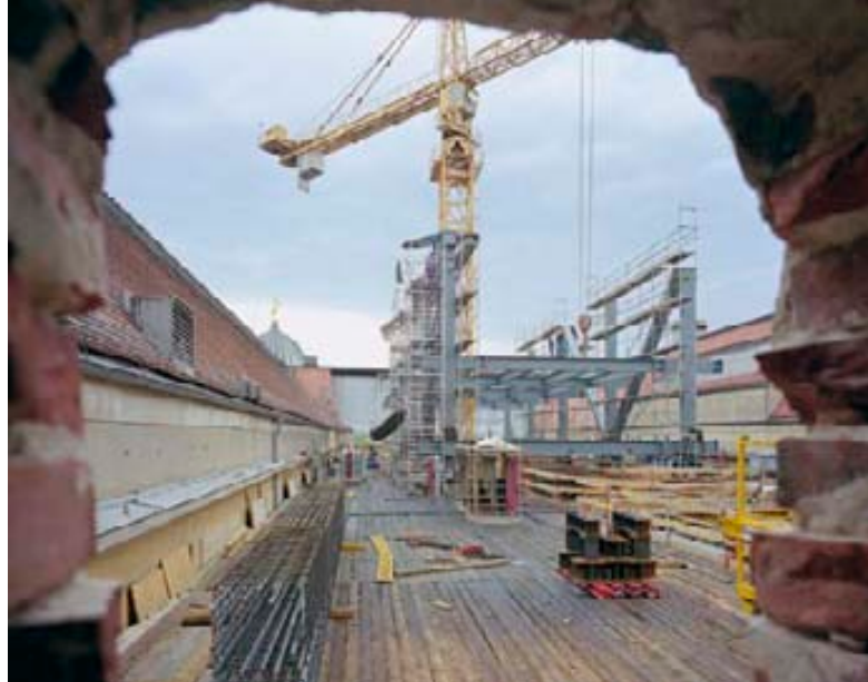
Die Stahlkonstruktion wurde im mittleren Bereich 15 Zentimeter überhöht errichtet. Erst mit dem »Einhängen« durch die Eigenlast des Rohbaus entstand die Flucht.
