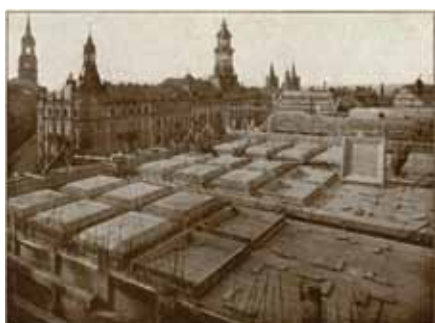
Konstruktive Ausbildung der Kassettendecke, Baustellenfoto und zeitgenössische Detailzeichnung
