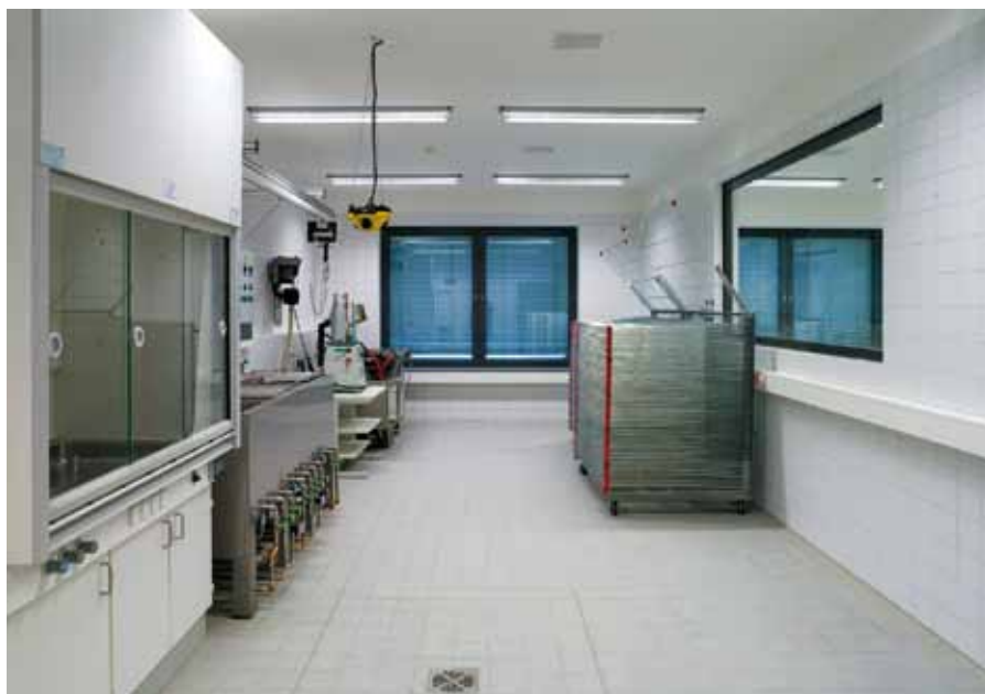
Werkstattbereich des Archivneubaus mit Laboreinrichtungen zur Papierbearbeitung
