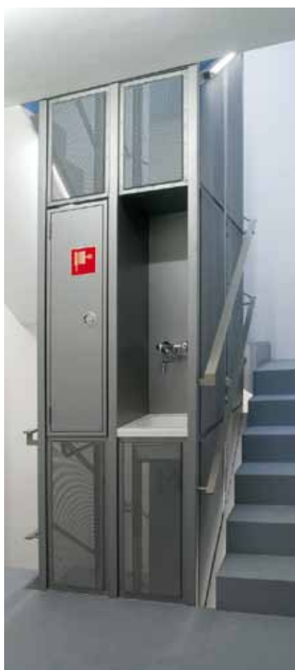
Treppenhaus mit Installationsschacht und Wasserentnahmestelle
