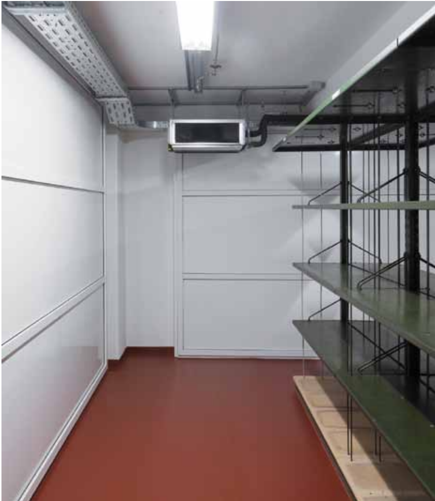
Archivraum (Ecksaal) nach Fertigstellung der Dämmebene, die Fenster sind vollständig verschlossen, Umluftkonvektor wurde an der Decke installiert.
