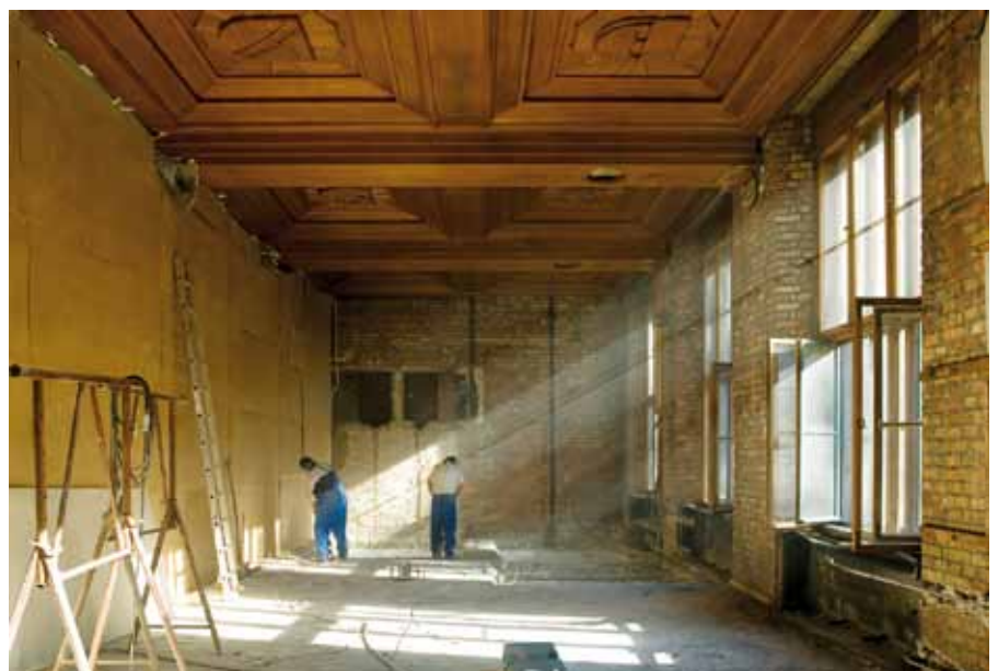
Bauarbeiten im historischen Lesesaal
