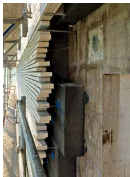
Die Fassade während der Bauphase
