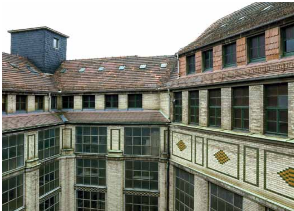
Der Lichthof des Magazinaltbaus vor der Sanierung
