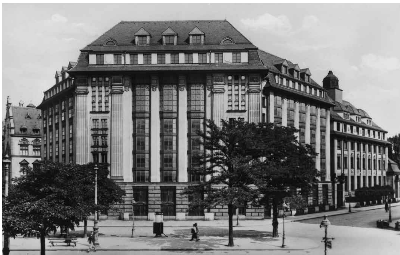
Hauptfassade des Magazinegebäudes des Staatsarchivs zum früheren St. Privatplatz, Fotoaufnahme um 1920
