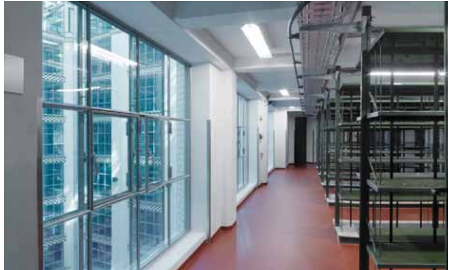
Fenster eines Archivraums an der Lichthoffassade, rechts vor und links nach der Sanierung, die historischen Fenster wurden erhalten
