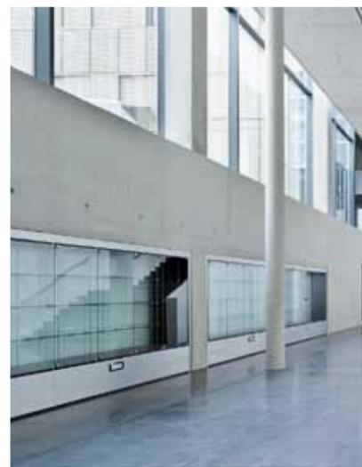
Erweiterungsneubau, ein Stahlbetonskelett-Bau mit Verbindungsbauten aus Stahl-Glaskonstruktionen
