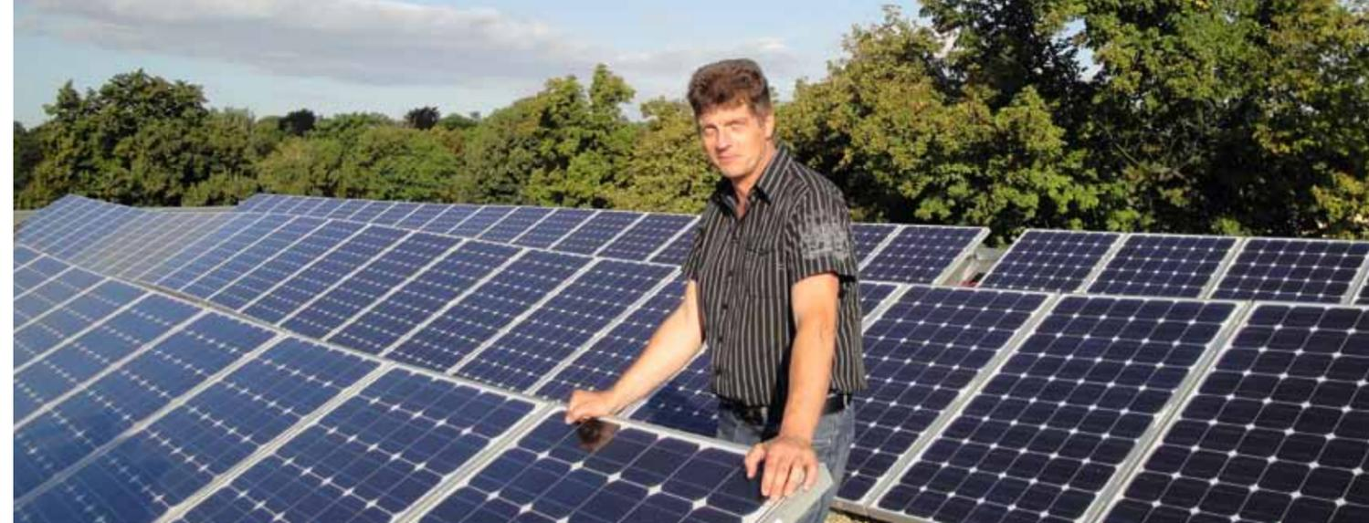
Bürgersolaranlage auf dem Dach des Finanzamtes Eilenburg (09/2010). Die Anlage besteht aus 187 Photovoltaikmodulen. Die maximale Leistung beträgt 41 Kilowatt. Mit dem erzeugten Solarstrom können jährlich rund 20 Tonnen CO<sub>2</sub> gegenüber Energieerzeugung mit fossilen Brennstoffen eingespart werden.
