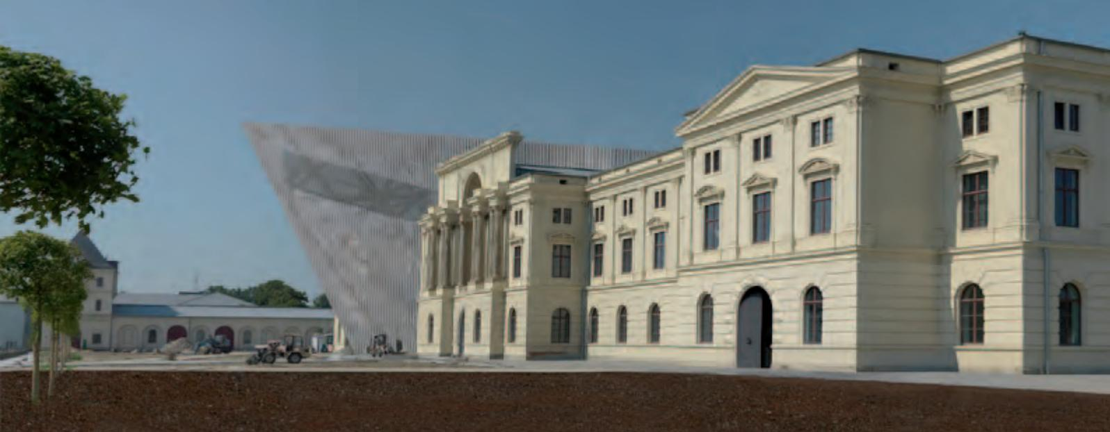
Der Keil aus Stahlbeton, der den Altbau „durchschneidet“, musste bei seiner Konstruktion innerhalb des Altbaus in allen Phasen des Bauens statisch gesichert werden. Erst mit der Betonierung und Aushärtung der Dachdecke wurde die Gesamtstabilität erreicht und der Neubau in sich selbst tragfähig, sodass die Sicherungsmaßnahmen entfernt und mit dem Innenausbau begonnen werden konnte.
