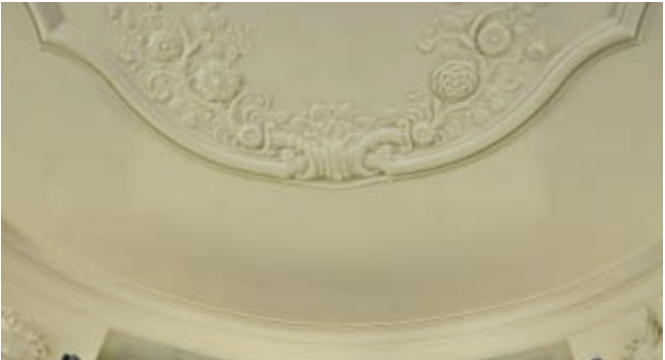
Deckenstück im Treppenhaus des Vorderhauses
