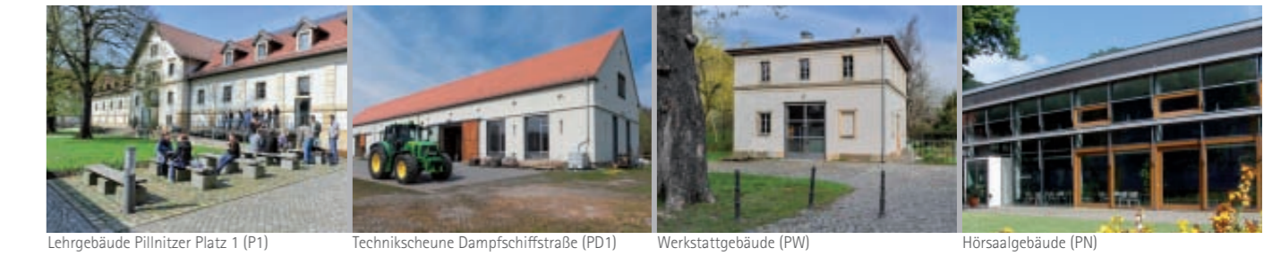
Lehrgebäude Pillnitzer Platz 1 (P1)
