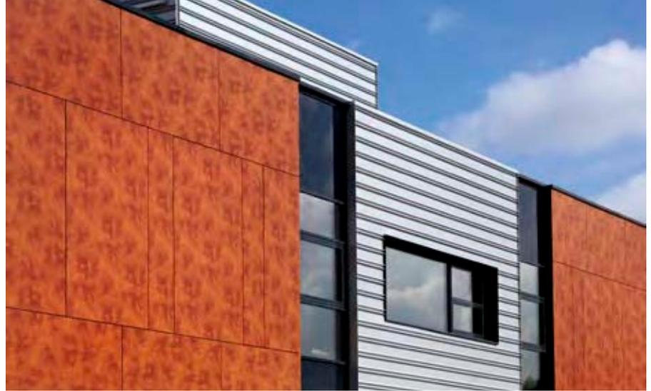
Fassadengestaltung mit Hochdruck-Schichtpressstoffplatten (HPL) und Aluminium
