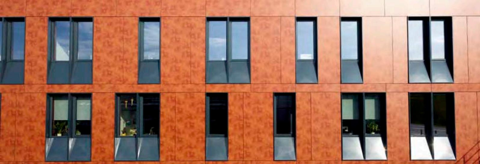
Vorgehängte hinterlüftete Fassade
