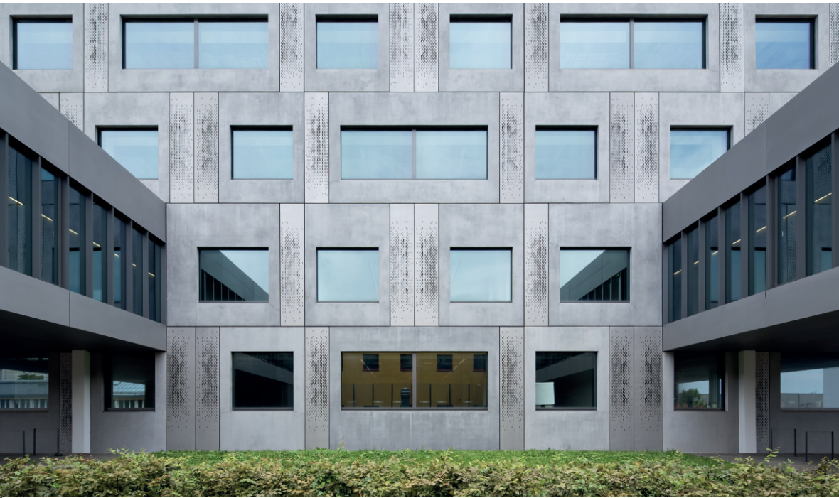
Ansicht Nord mit Übergraben zur Halle H | 11
