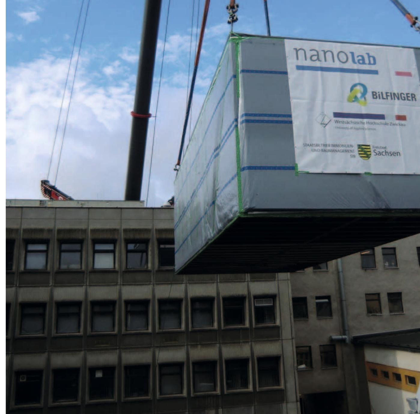
Einsetzen des modularen Reinraumlabors mittels Automobilkran über das Gebäude des Technikums II der WHZ
