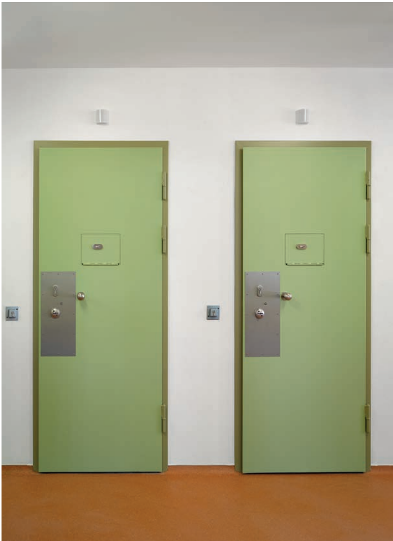
Haftraumtür nach dem Umbau
