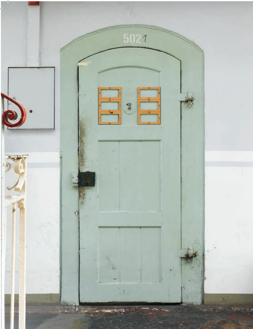
Haftraumtür vor dem Umbau
