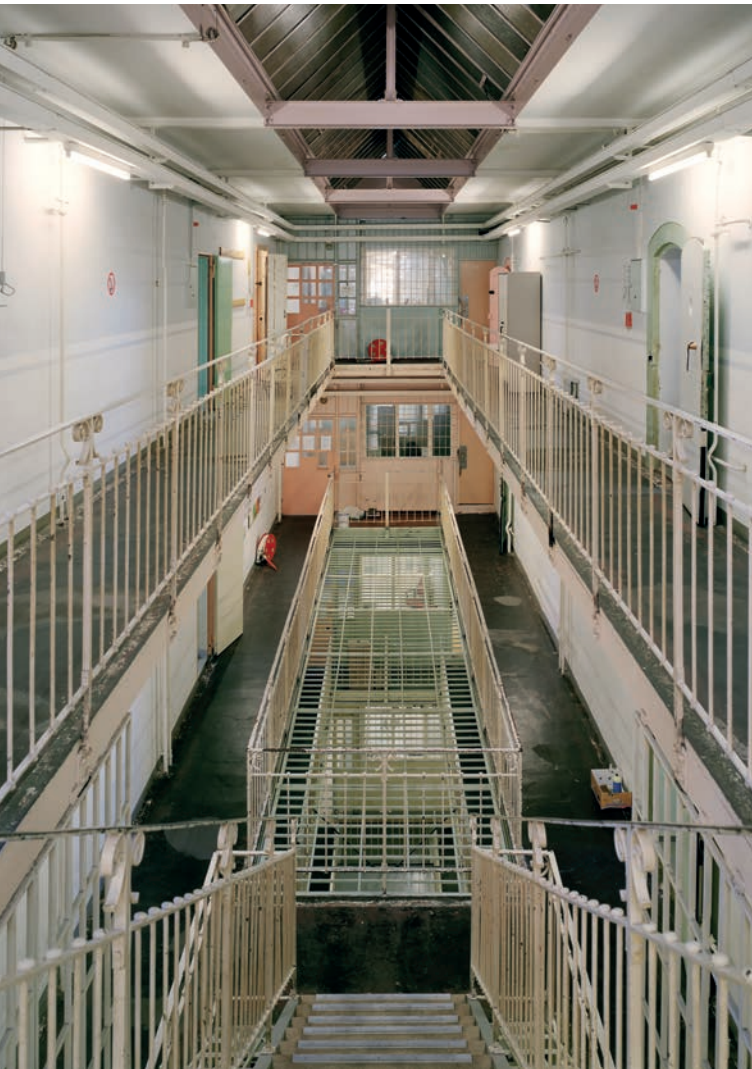
offenes Treppenhaus vor dem Umbau
