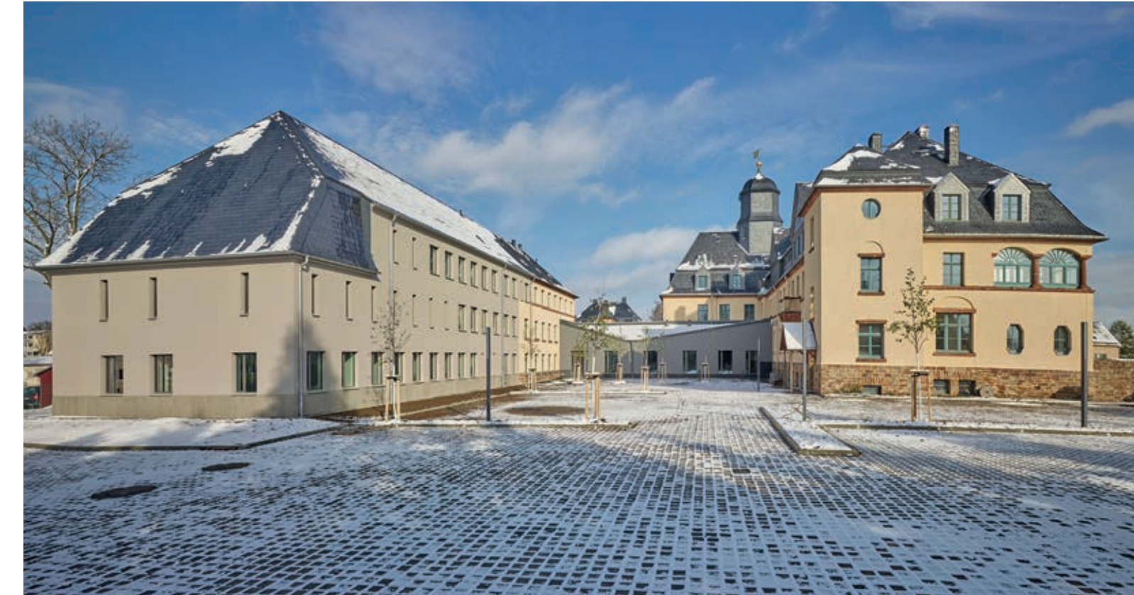
Innenhof mit neuem Verbindungsgebäude
