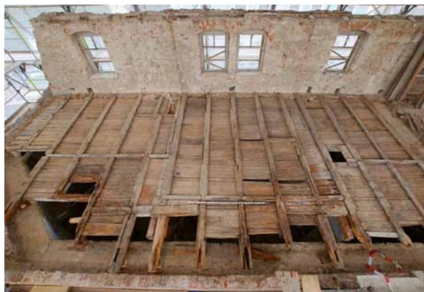
Sicherung und Sanierung der bemalten Holzbalkendecke im Herrenhaus
