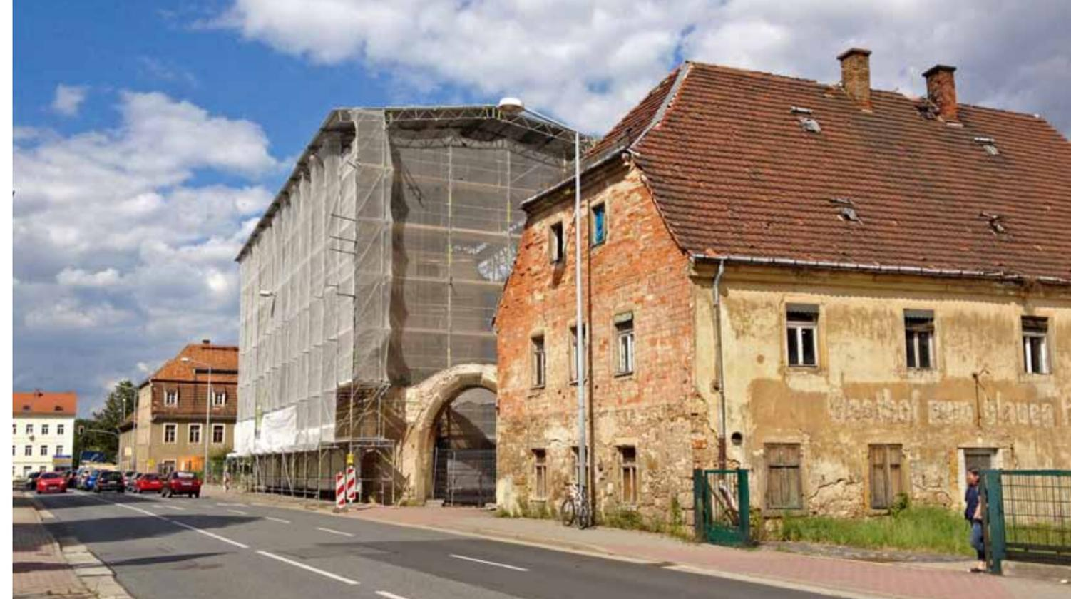
Im August 2013 ist das Vorwerk mit einem Wetterdach zur Sanierung der Baukonstruktion und zur Rekonstruktion des Daches gesichert.
