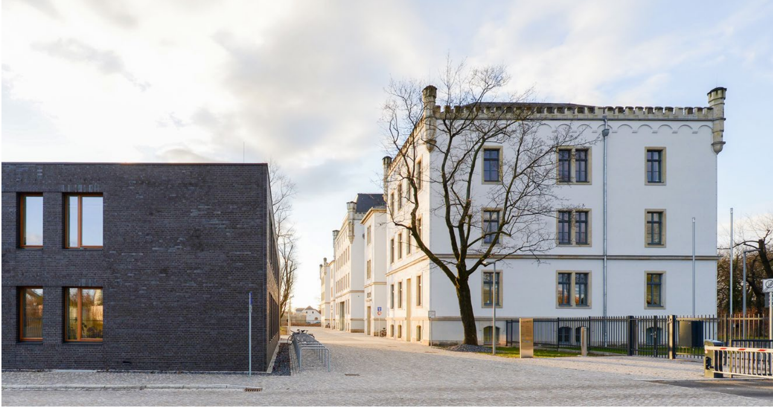
Im architektonischen Kontrast, Erweiterungsbau und sanierter Altbau
