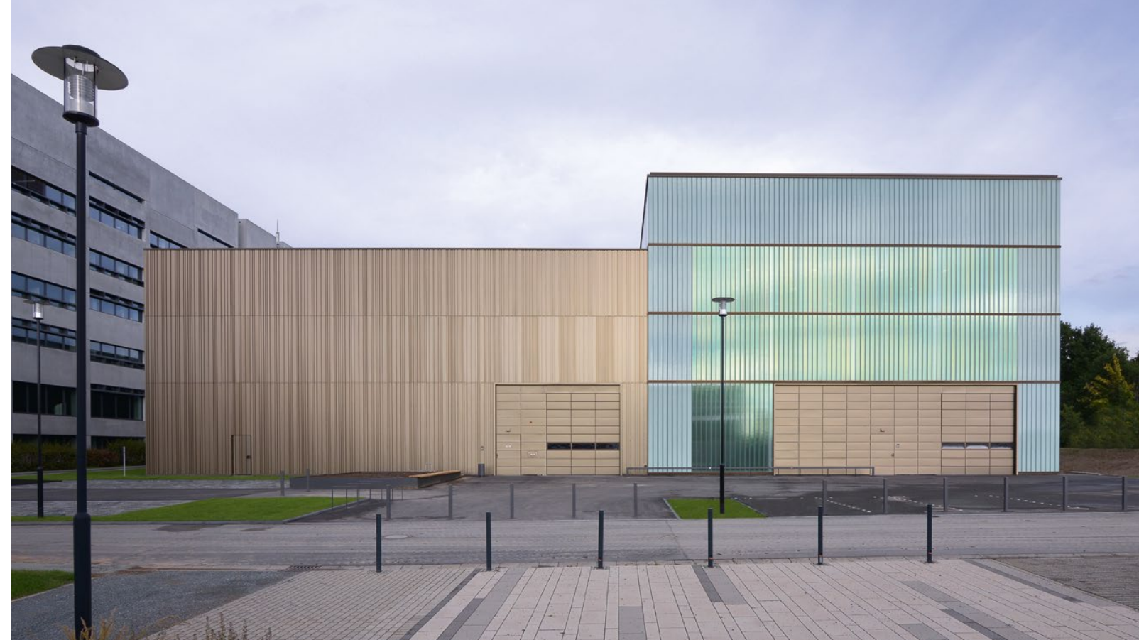
Außenansicht, die Glasfassade der Halle B setzt sich von der bronzefarbenen Aluminiumfassade der Halle A ab
