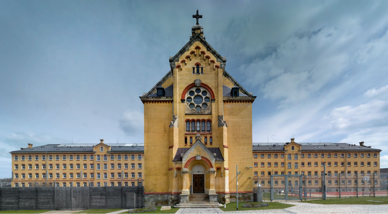
JVA Bautzen, Sanierung Haus 1 (Ost-West-Flügel) – Anstaltskirche im Vordergrund
