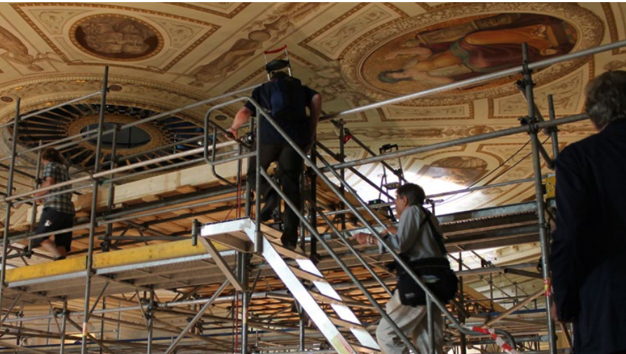
Bauunterhalt der Semperoper Dresden, Sanierung des Zuschauerraums in der Spielzeitpause 2015
