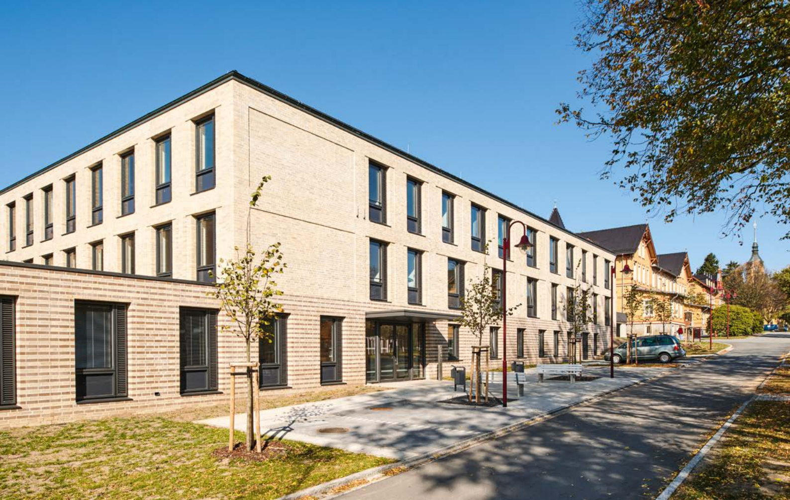
Neubau des Gerontopsychiatrischen Zentrums
