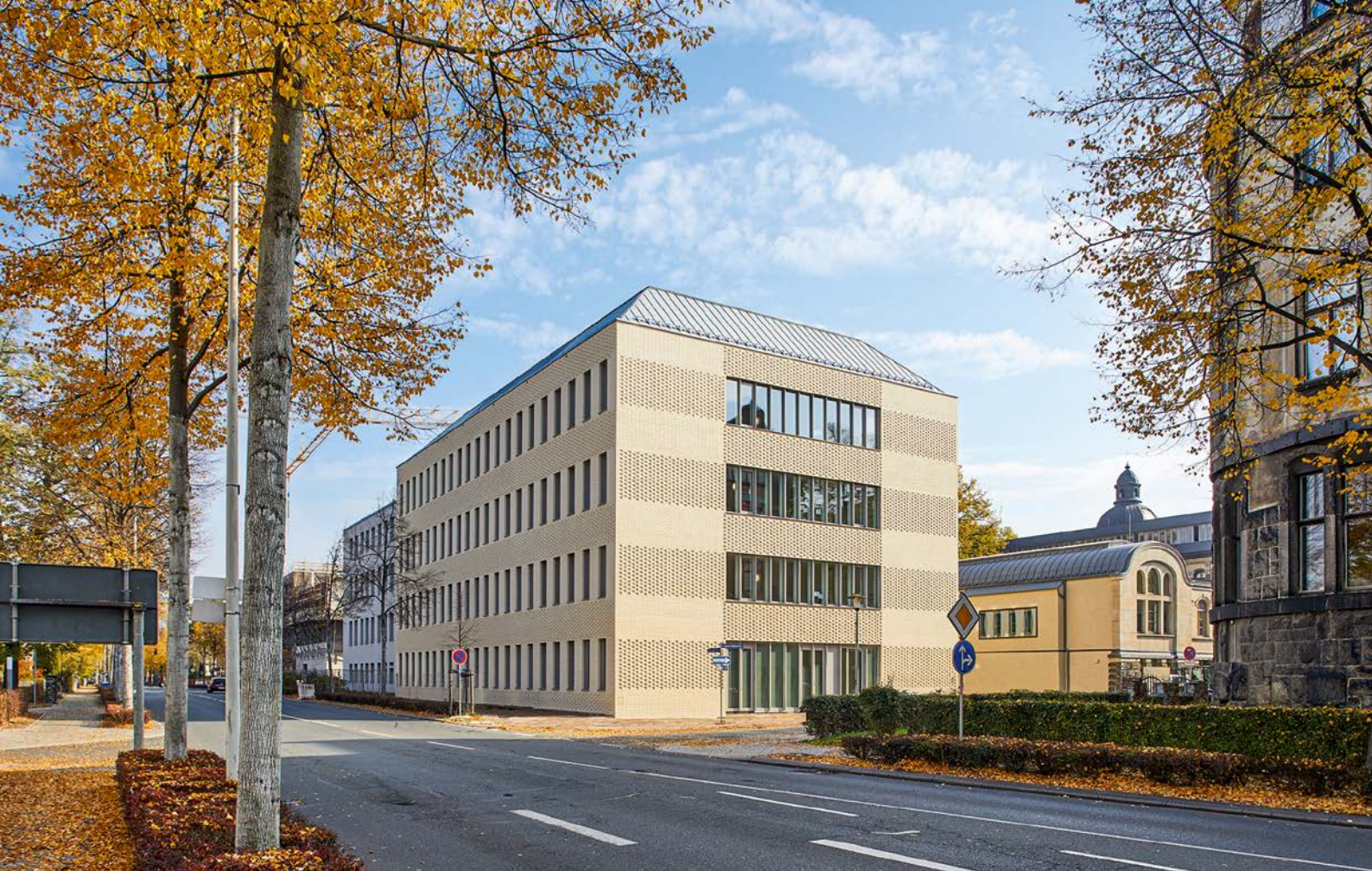
Erweiterungsneubau mit Verbindungsbau
