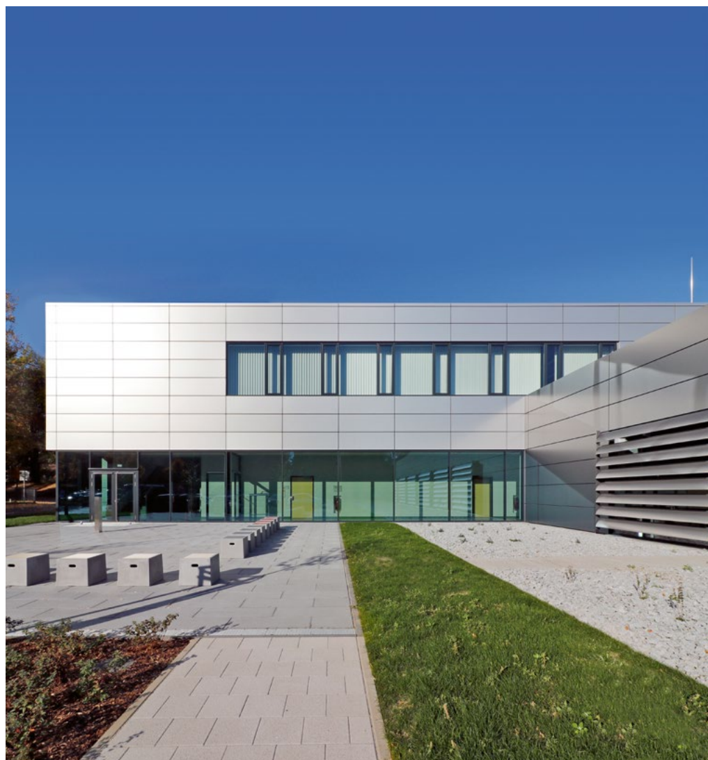
Laborgebäude, Staatliche Studienakademie Bautzen
