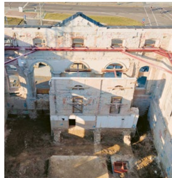
Historisches Streifenfundament mit Blick aus Süden, Nordwand mit Rest der historischen Innenwand
