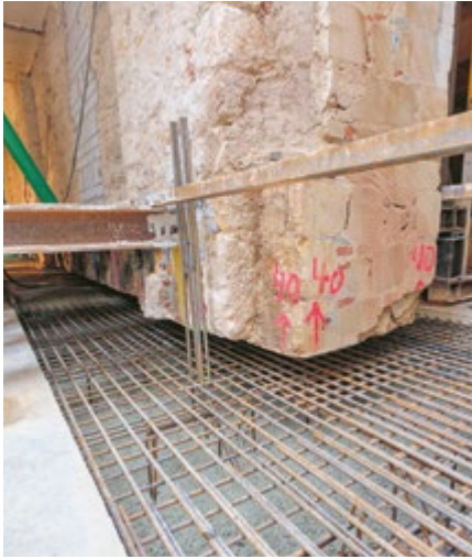
Unterfangung der historischen Innenwand
