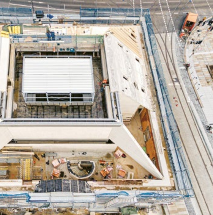
Vogelperspektive Anschluss Kubus an die Konsolen, oberer und unterer Ringbalken (links), Anschluss Kubus an Konsolen inkl. oberer Stahl-Ringbalken aus Sicht Galerie (rechts)
