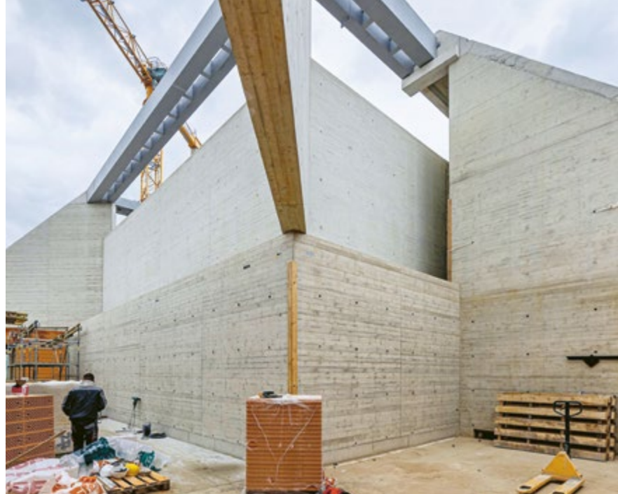
Vogelperspektive Anschluss Kubus an die Konsolen, oberer und unterer Ringbalken (links), Anschluss Kubus an Konsolen inkl. oberer Stahl-Ringbalken aus Sicht Galerie (rechts)
