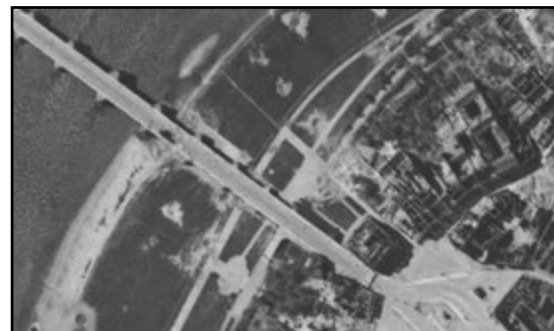
Nach den Bombardements vom 31.05.1944, 22.03.1945 und 19.04.1945 angefertigte Luftaufnahmen zeigten Einschläge. Luftbild: Datenbank Dr. Carls GmbH. Luftbildscan Große Meißner Straße vom 19.04.1945
