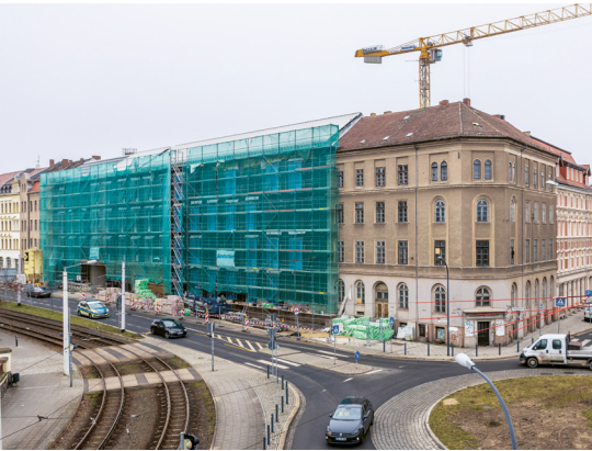
Auf dem Gelände an der Ecke Bahnhofstraße/Jakobstraße in Görlitz entsteht der neue Gebäudekomplex.
