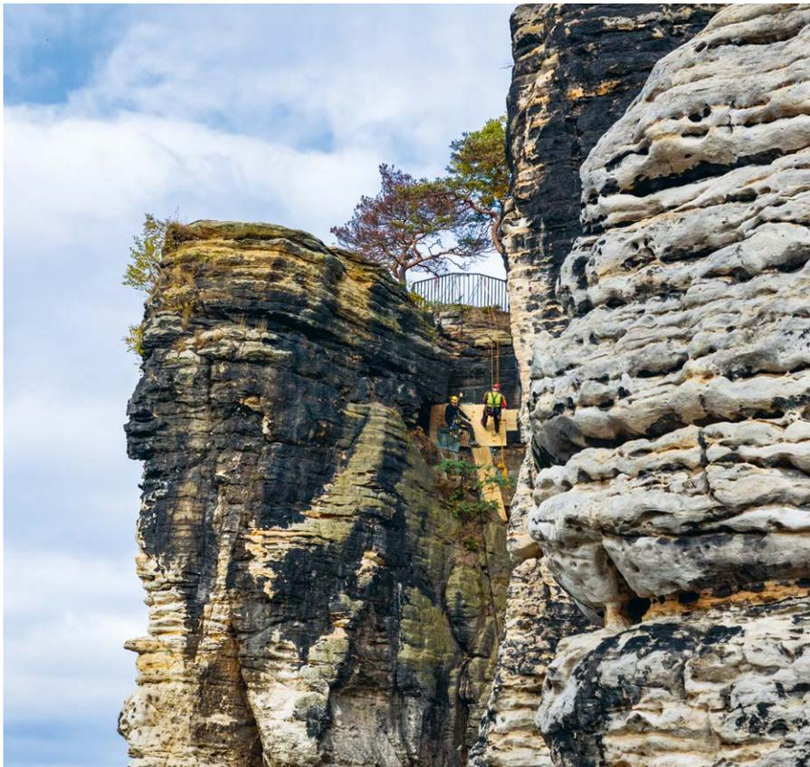
Vor diesem Hintergrund wurden im Jahr 2016 Felssicherungsmaßnahmen am vorderen Teil des Basteifelsens in Auftrag gegeben. Bei den durchgeführten Kernbohrungen für den Einbau von Felsnägeln konnten zum Teil keine Bohrkerne mehr gewonnen werden, da das Gestein im Inneren des Felsens überwiegend nur geringe Festigkeiten aufwies. Mitte 2016 mussten daher die vorderen zehn Meter der Basteiaussicht aufgrund des schlechten Zustandes des Felsuntergrundes gesperrt werden.
