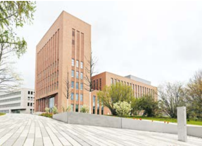
Das Zentrum ist das Auftakt-Gebäude des städtebaulichen „Wissenschaftskorridors“, der die Hochschulverwaltung in der Altstadt mit dem Campusgelände im nördlichen Teil Freibergs verbinden soll.
