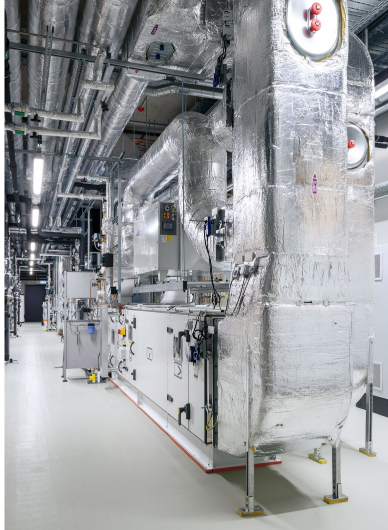
Blick in den Technikbereich
