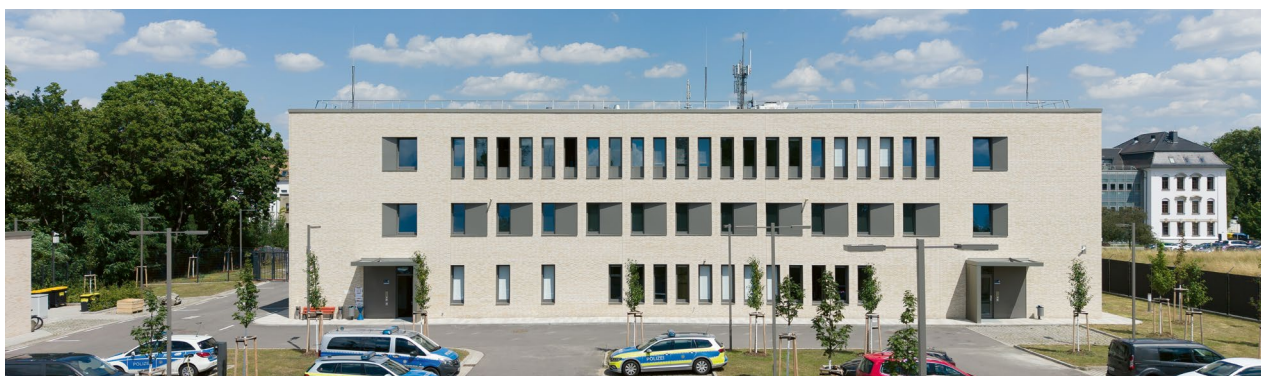
Fassadenseite zum Polizeihof
