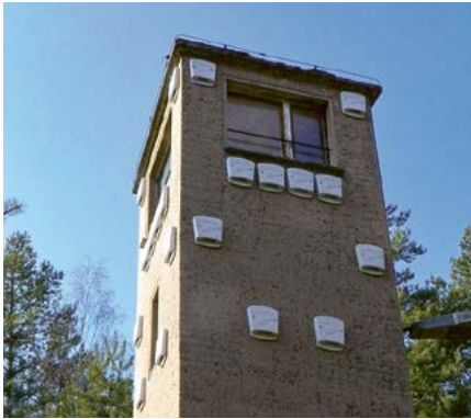
Der verbliebene Postenturm wurde mit Fledermauskästen ausgestattet.
