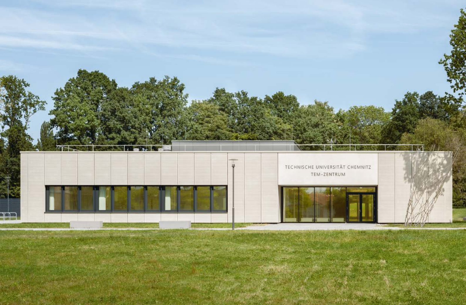
Das Transmissionselektronenmikroskopiezentrum als moderner Forschungsstandort auf dem Campusgelände der TU Chemnitz
