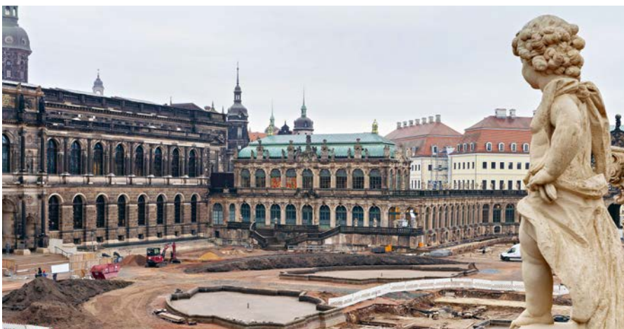
Der Zwingerhof während der Sanierung
