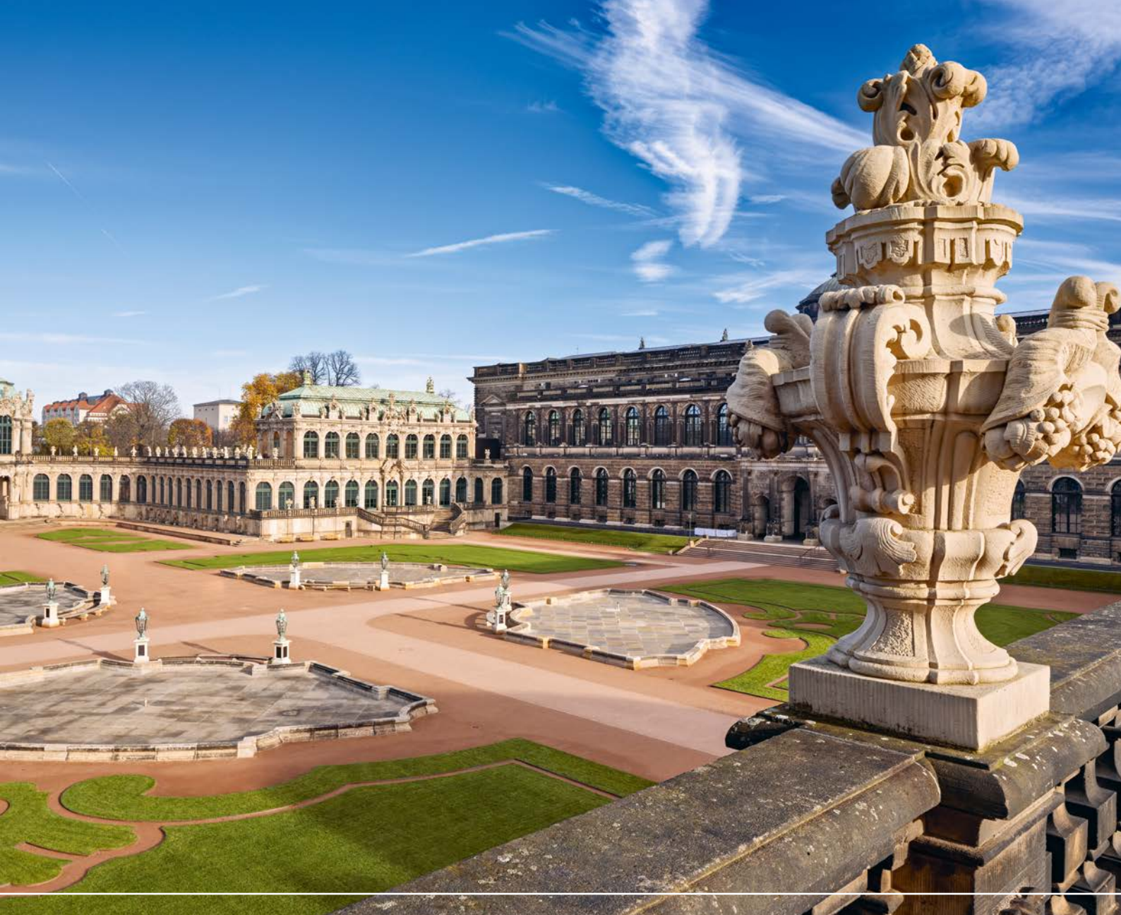
Blick in den sanierten Zwingerhof
