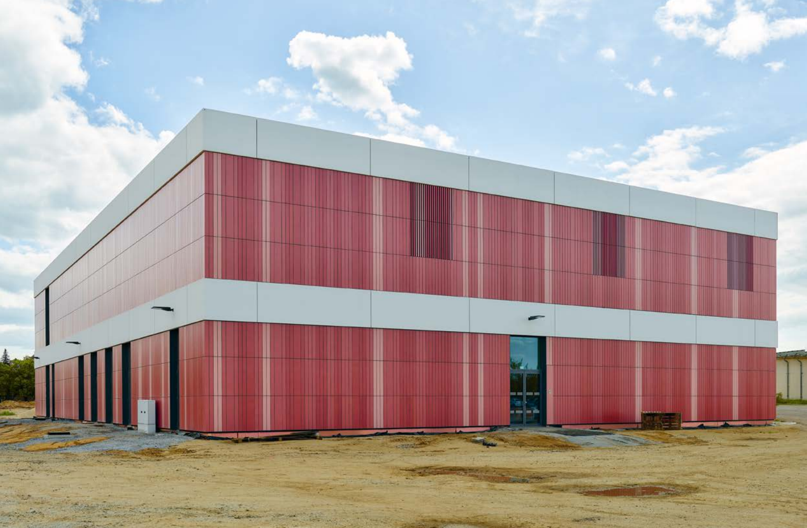
Die rote Fassade der neuen Raumschießanlage nimmt Bezug auf den roten Natursteinsockel der historischen Kasernengebäude
