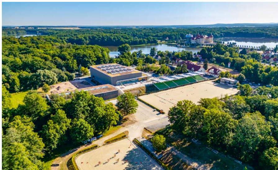
Die neue Multifunktionsreithalle in Holz-Hybridbauweise wurde 2025 an das traditionsreiche Landgestüt Moritzburg übergeben
