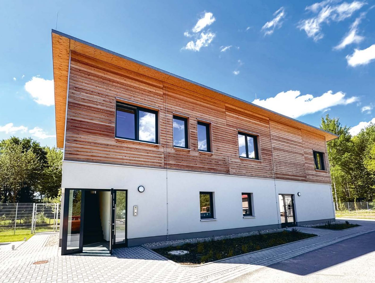
Das Obergeschoss in seiner leichten Holzrahmenbauweise nimmt Bezug auf die Forstwirtschaft
