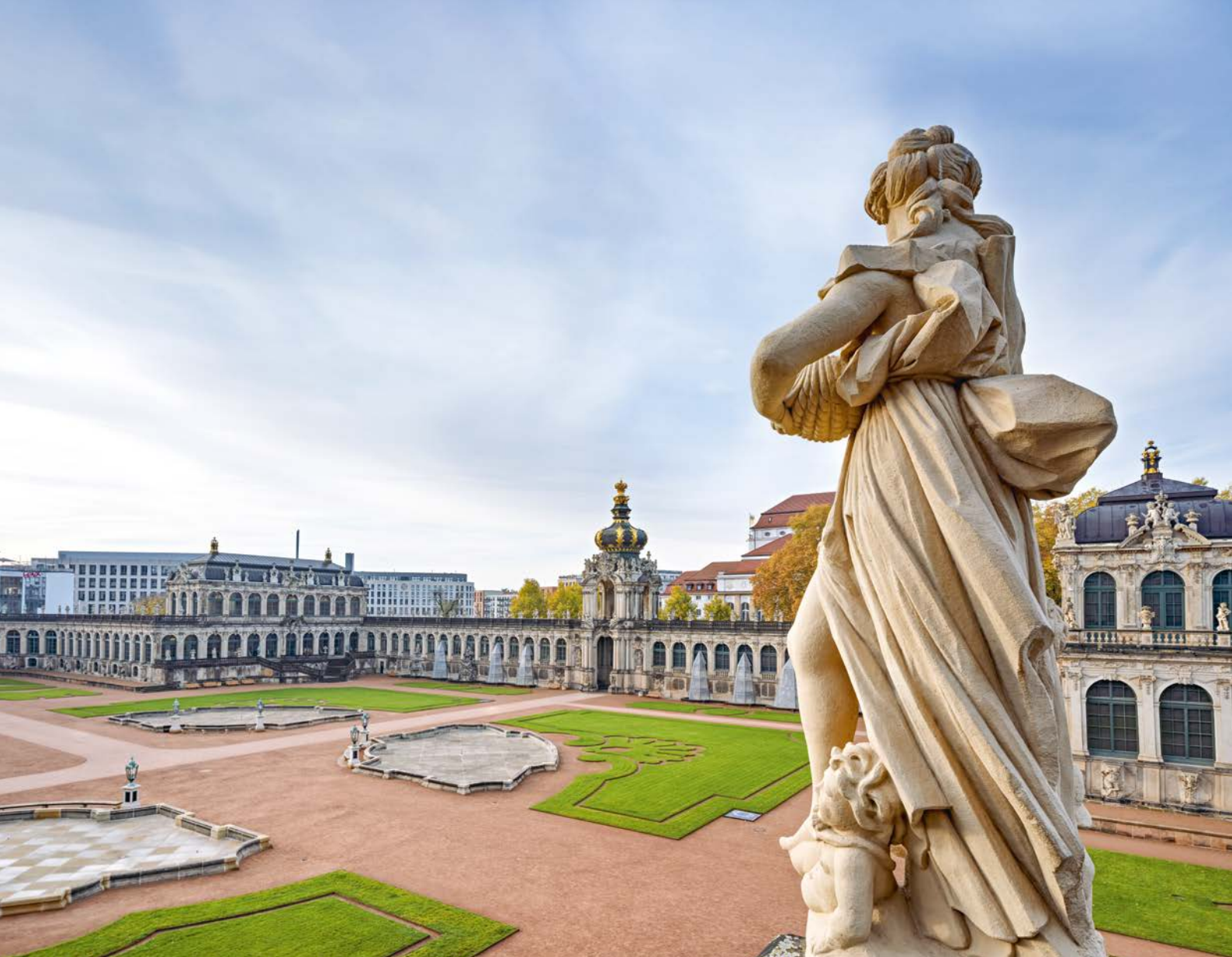
Blick in den sanierten Zwingerhof
