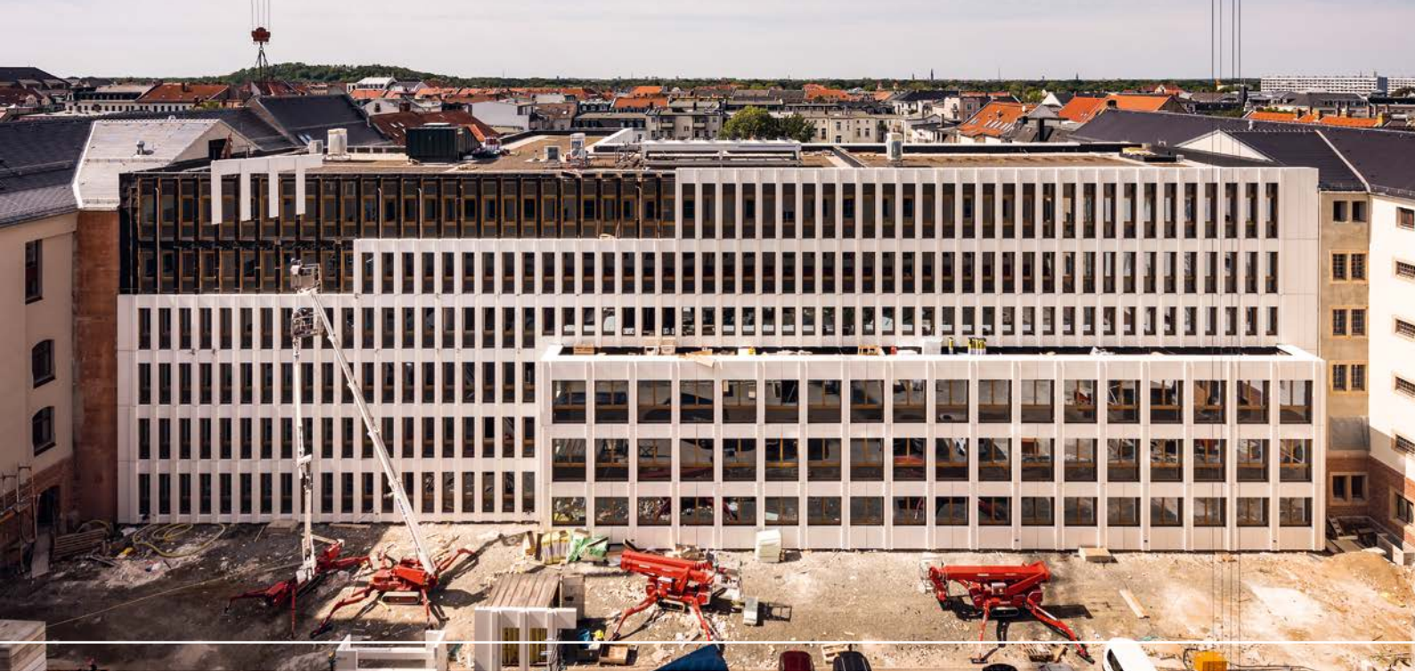
Justizzentrum Leipzig – 1. Bauabschnitt, Staatsanwaltschaft
