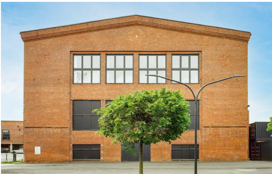
Die Klinkerfassade des Industriebaus ist geprägt durch eine klare Ästhetik
