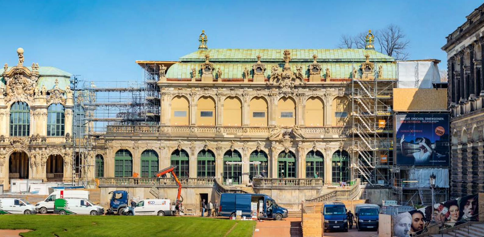
Aufwändige Sanierung des Französischen Pavillons, außen wie innen
