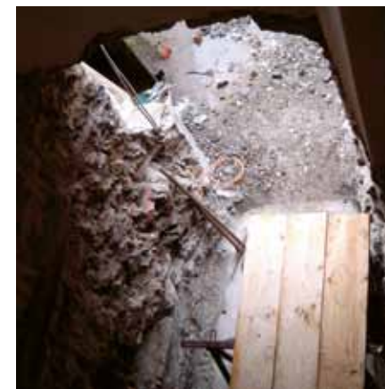
Schachtvortrieb für den Aufzug
